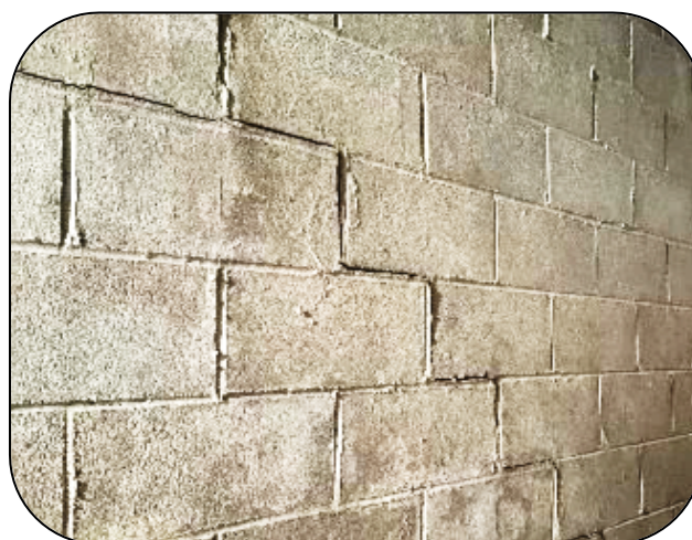
Fig. 23. Stair-steps fractures
