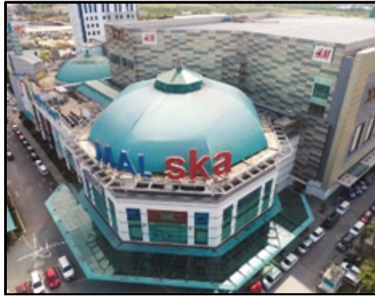
Fig. 1. SKA Mall Pekanbaru Dome
